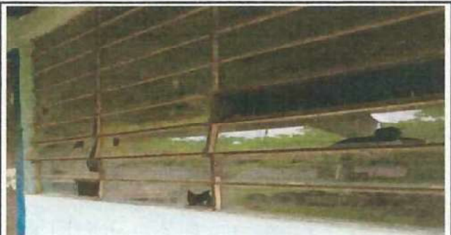
Foto 4: Sustitución de vidrios en ventanales del Módulo 1
